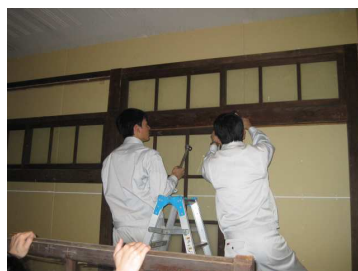
柱の取り付けと 平行バランスの調整
